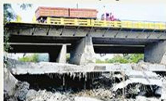
A simple vista pueden observarse claramente las fallas que comprometen las bases de la estructura
